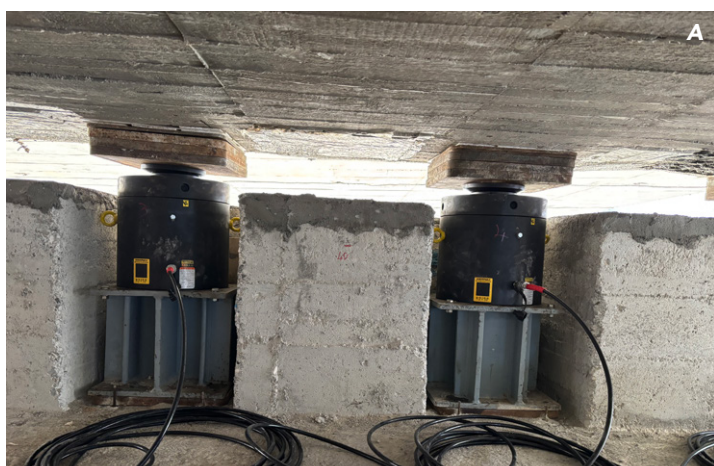
2A e 2B. Martinetti da 600 tonnellate posizionati su pila 19
