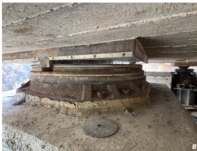
5A e 5B. Distacco appoggio a seguito sollevamento
