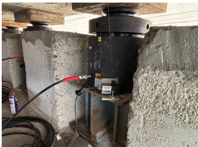
4. Sollevamento in corso Pila 19
