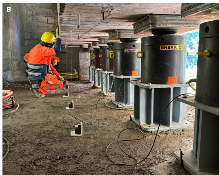
3A e 3B. Controllo collegamenti idraulici martinetti pila 19 (A). Posizionamento sensori spalla 2 (B)
