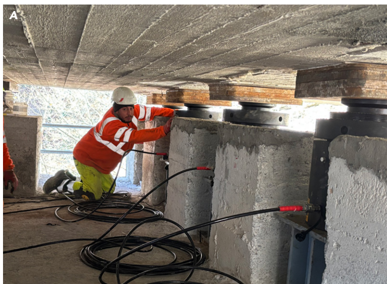
3A e 3B. Controllo collegamenti idraulici martinetti pila 19 (A). Posizionamento sensori spalla 2 (B)
