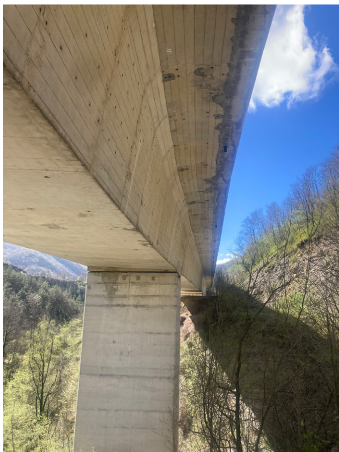
8. Vista Viadotto da Pila 19 verso pila 18
